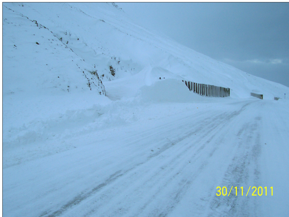
Mynd 12. Snjóflóðaskáparnir þrír skömmu eftir að mynd 10 var tekin. Skápurinn næst á myndinni hefur þegar stöðvað snjóflóð.
